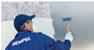
Aplicación del Hempel's Underwater Primer sobre las superficies preparadas
