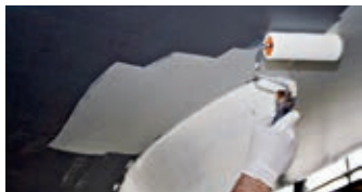
Aplicación del antiincrustante sobre la imprimación.
