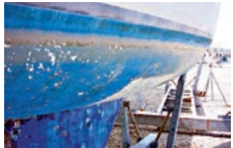
Burbujas y desprendimientos
