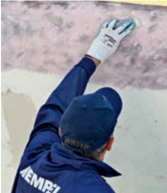
Enmasillado en la línea de flotación
