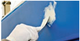
Enmasillado de los agujeros pequeños usando una espátula
