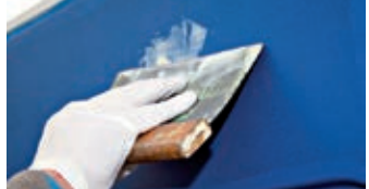
Enmasillado con el uso de una llana
