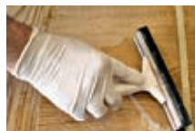
Eliminar agua sucia y restos de lijado
