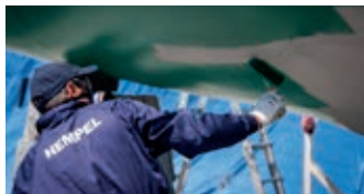
Aplicación del antiincrustante sobre la imprimación o capa puente
