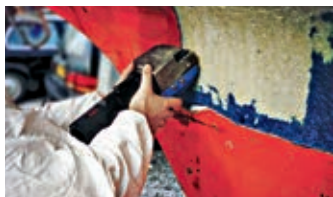
Pelando el gelcoat con una peladora (gelcoat peeler)
