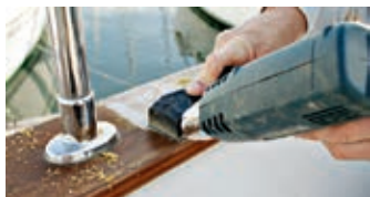
Eliminación del barniz antiguo con una pistola de aire caliente
